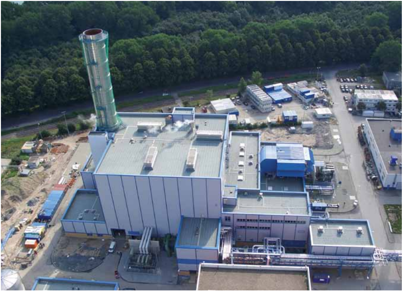
Heizkraftwerk Niehl der RheinEnergie im Norden Kölns.
