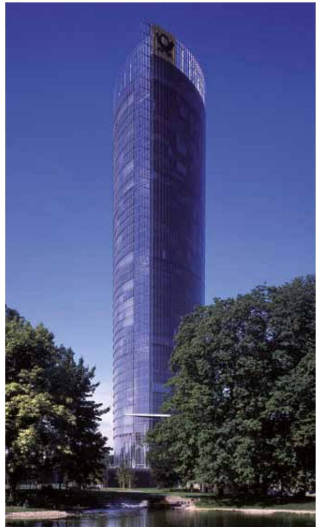
Post Tower der Deutsche Post AG.
