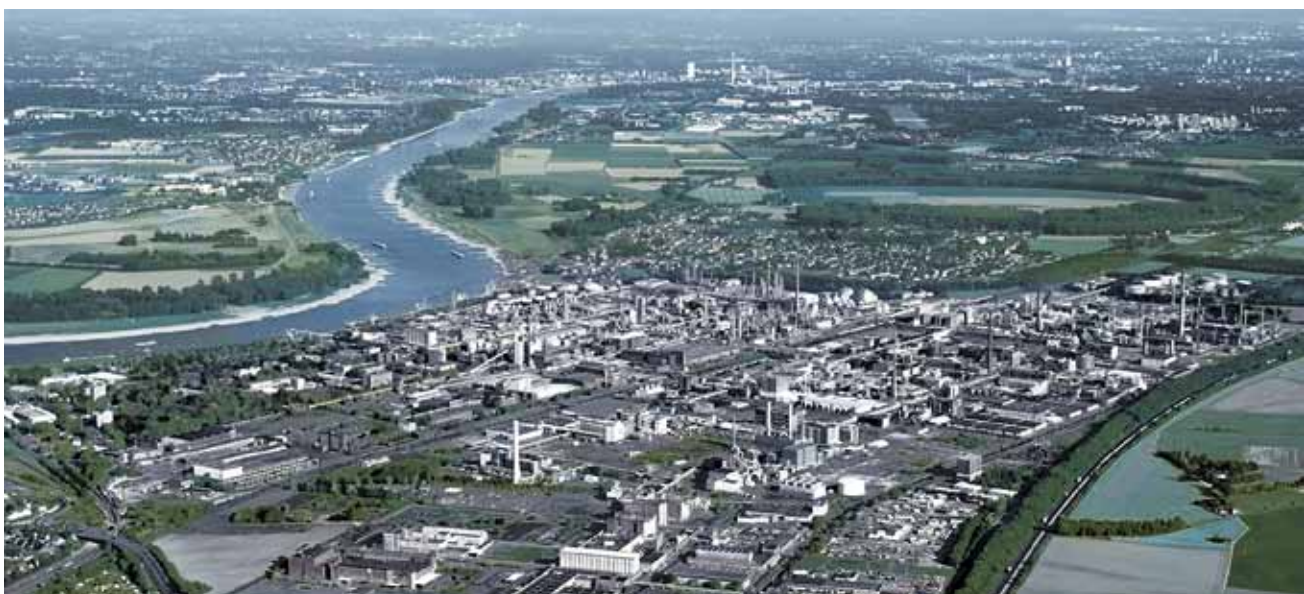
Energieintensive Unternehmen, wie etwa die der Chemieindustrie, profitieren vom vergleichsweise günstigen Strom – Chempark Dormagen.
