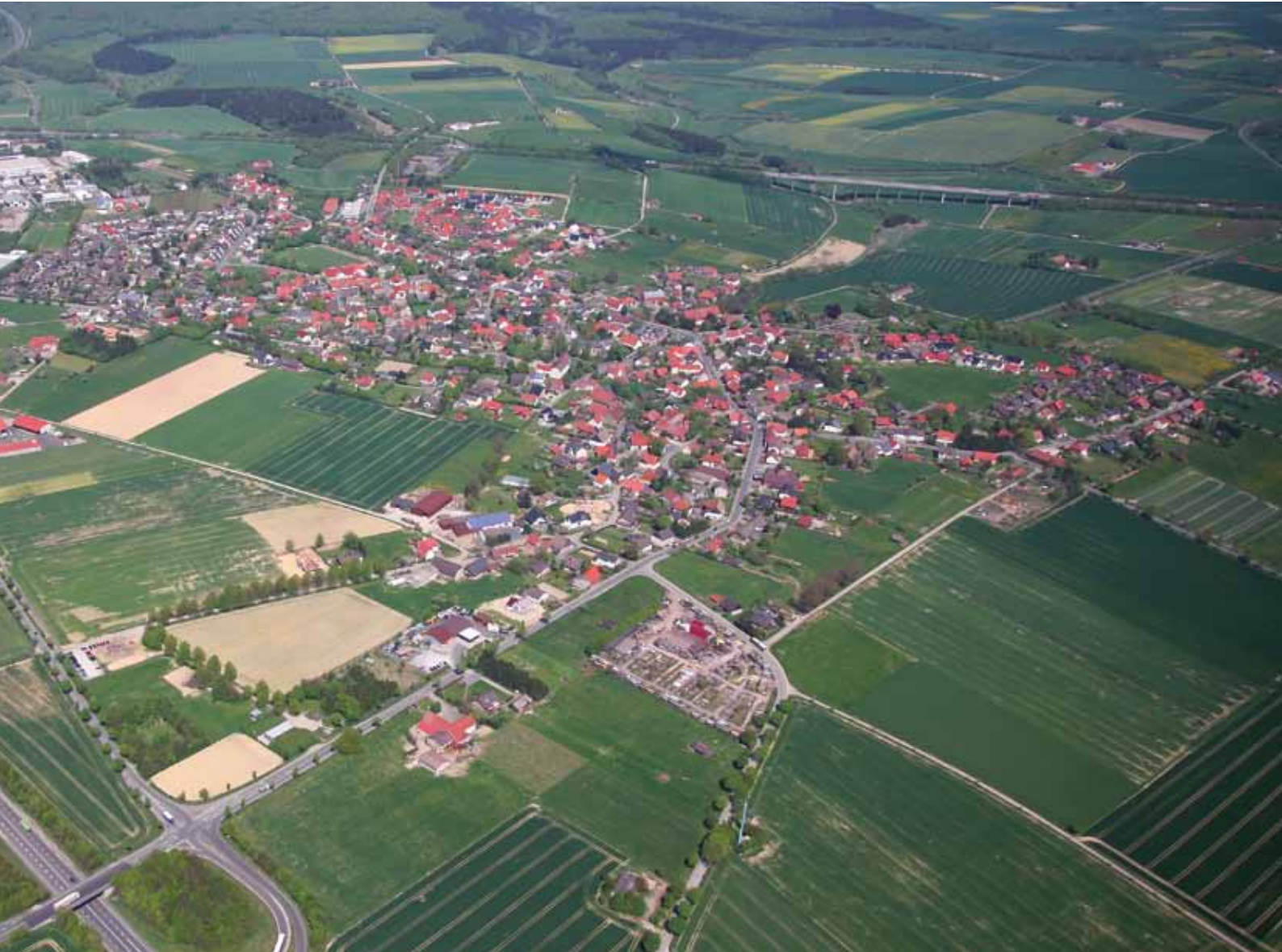
Gewerbe- und Industriebetriebe an Verkehrsachsen – hier das Gewerbegebiet Haaren am Autobahnkreuz Wünnenberg-Haaren (A 33/A 44 im Hintergrund). Im Vordergrund die Abfahrt von der Bundesstraße B 480, Gewerbegebiet Haaren.
