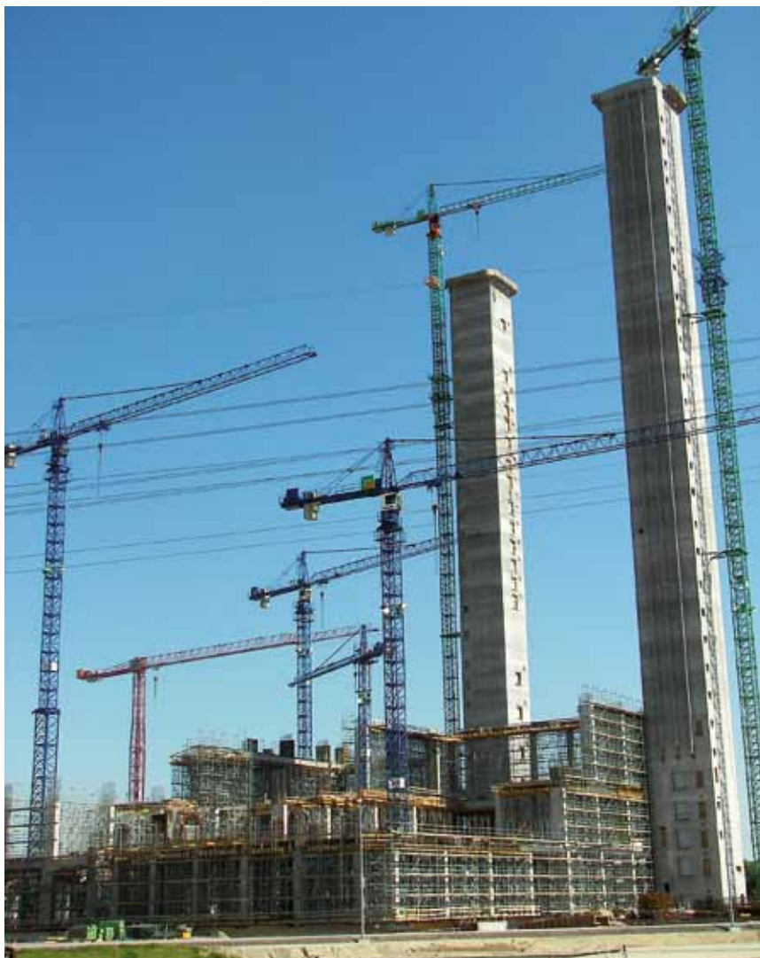
Das im Bau befindliche Kohlekraftwerk Datteln am Dortmund-Ems-Kanal, Anfang Mai 2008. Baubeginn war im November 2007. E.on errichtet ein komplett neues Kraftwerk: Datteln 4. Die Inbetriebnahme ist für 2011 vorgesehen. Das neue Kraftwerk wird unter anderem die veralteten Kraftwerksblöcke Datteln 1 bis 3 ersetzen, die bis 2015 abgeschaltet werden sollen. Das neue Kraftwerk liegt gegenüber des alten, auf der anderen Kanalseite. Betrieben wird es mit Steinkohle. Im alten Kraftwerk Datteln werden allein 20 Prozent des Stroms für die Deutsche Bahn erzeugt. 45 Prozent aller Haushalte in Datteln beziehen vom Kraftwerk Fernwärme.
